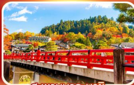
สะพานนากะบาชิ
